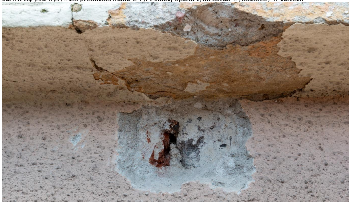
Fot. 28, 29. Odkrywka nr 1 na obramieniu okna na bocznej ścianie wieży kościoła. Na profilu zachowała się wyprawa z początku XX w., kiedy wieżę podwyższono oraz tynk, którym w późniejszych latach wykonano naprawy. Kolor pomarańczowy to efekt powojennego remontu (być może pierwotnie był to kolor różowy, ale przebarwił się pod wpływem promieniowania UV). Poniżej opaski tynk został wymieniony w całości.
