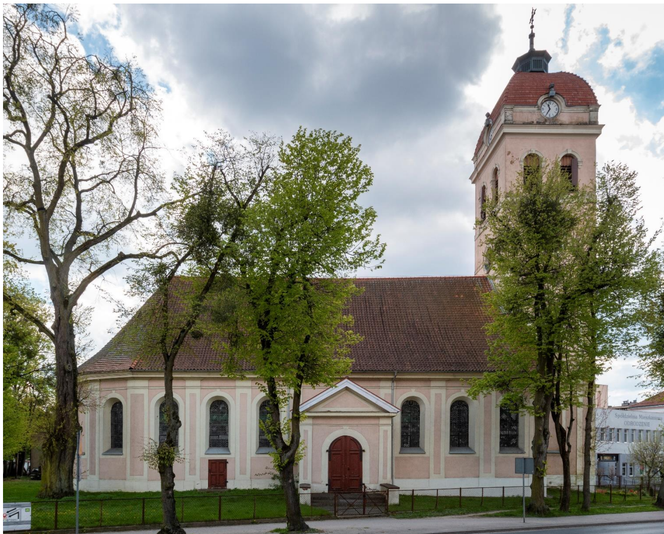
Fot. 24. Kościół współcześnie, elewacja północno-zachodnia.
