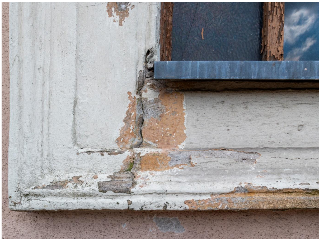
Fot. 28, 29. Odkrywka nr 1 na obramieniu okna na bocznej ścianie wieży kościoła. Na profilu zachowała się wyprawa z początku XX w., kiedy wieżę podwyższono oraz tynk, którym w późniejszych latach wykonano naprawy. Kolor pomarańczowy to efekt powojennego remontu (być może pierwotnie był to kolor różowy, ale przebarwił się pod wpływem promieniowania UV). Poniżej opaski tynk został wymieniony w całości.
