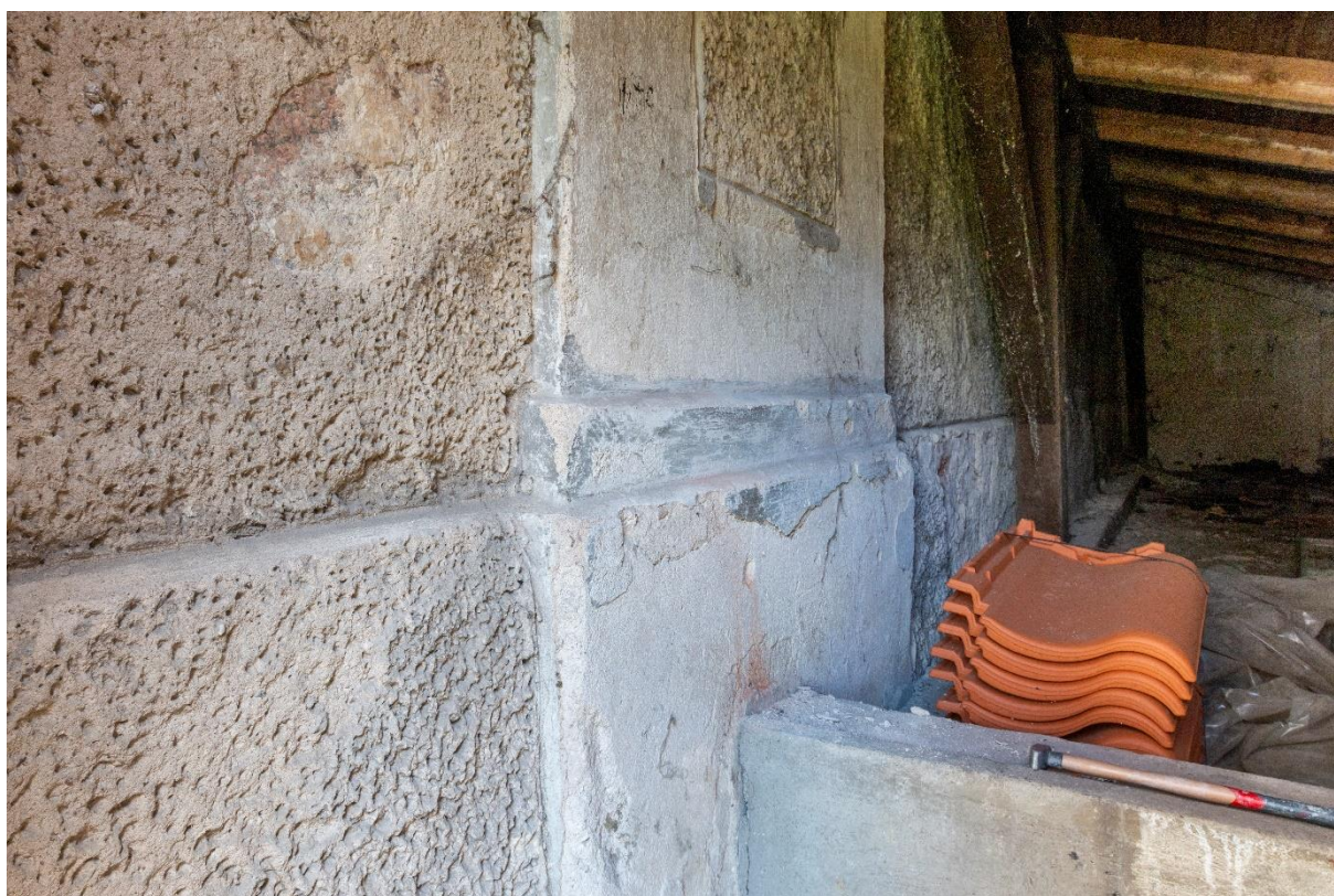
Fot. 19, 20. Cokół elewacji południowo-wschodniej. Tynk jest spękany oraz rozwarstwiony, z ubytkami w sąsiedztwie wykonanej w przeszłości żwirowej opaski. Na zdjęciu poniżej fragment nieusuniętego tynku, który zachował się na ścianie, do której przylega kotłownia. Widoczna różnica w głębokości oraz sposobie opracowania faktury w tłach. Inaczej otynkowano cokół – współcześnie tynk jest zagładzony na całej powierzchni, pierwotnie gładki był tylko na podstawach lizen, które także zostały uproszczone. Pierwotnie od cokołu oddzielone były niewielką bazą.
