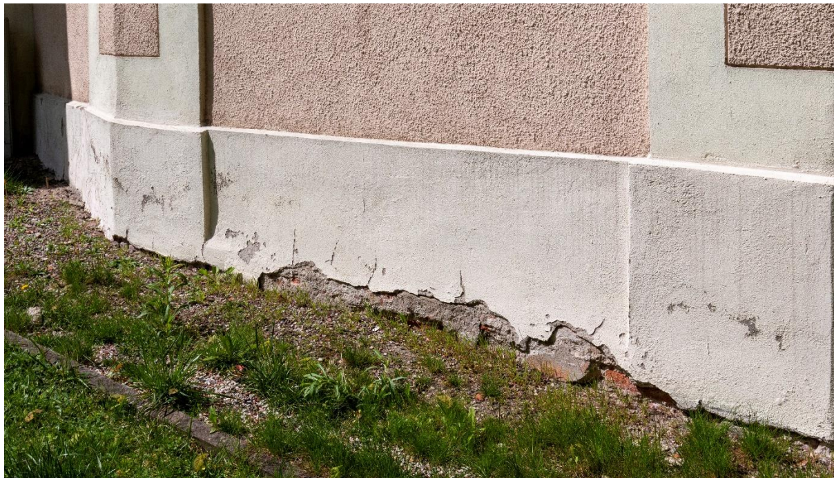
Fot. 19, 20. Cokół elewacji południowo-wschodniej. Tynk jest spękany oraz rozwarstwiony, z ubytkami w sąsiedztwie wykonanej w przeszłości żwirowej opaski. Na zdjęciu poniżej fragment nieusuniętego tynku, który zachował się na ścianie, do której przylega kotłownia. Widoczna różnica w głębokości oraz sposobie opracowania faktury w tłach. Inaczej otynkowano cokół – współcześnie tynk jest zagładzony na całej powierzchni, pierwotnie gładki był tylko na podstawach lizen, które także zostały uproszczone. Pierwotnie od cokołu oddzielone były niewielką bazą.
