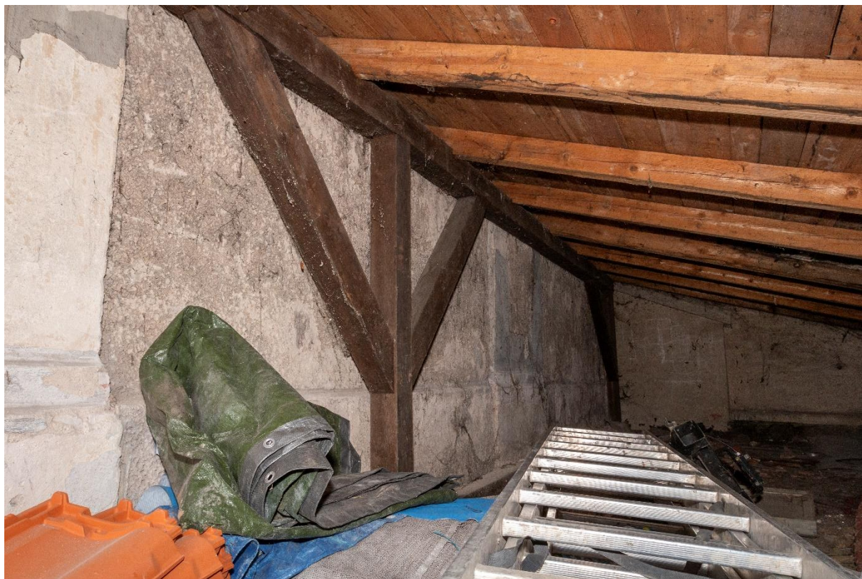
Fot. 32. Wnętrze kotłowni, którą w latach 30 XX wieku dobudowano do południowo-wschodniej elewacji kościoła. Podczas powojennych remontów ścian poniżej dachu kotłowni nie odnawiano, dlatego zachował się tam tynk z początku wieku, pod nim relikty starszej redakcji, być może pierwotnej z XVIII wieku.
