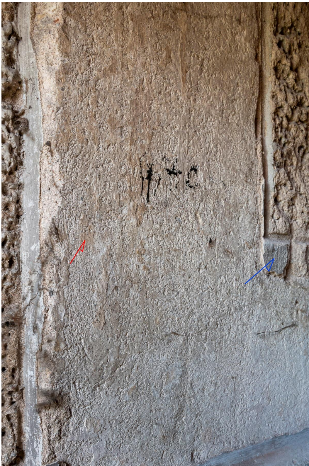
Fot. 37. Fragment lizeny na ścianie pod dachem kotłowni. Niebieską strzałką zaznaczono fragment zapobiałą, którą scalono powierzchnię i opracowano detal na początku XX w. Na lizenie zachowano wówczas starszy chronologicznie tynk z fragmentami jasnougrowej warstwy malarskiej (czerwona strzałka).
