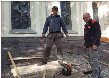
Panowie Tadeusz Caliński i Marcin Skalik wykonują otwór na piec w dachu
