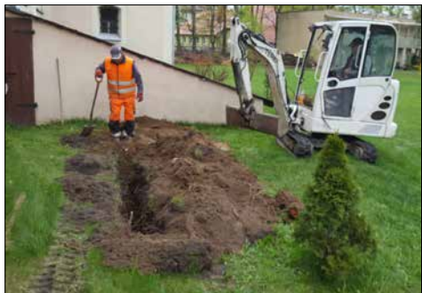
Pierwsze „podejście” do doprowadzenia gazu do przykościelnej kotłowni
