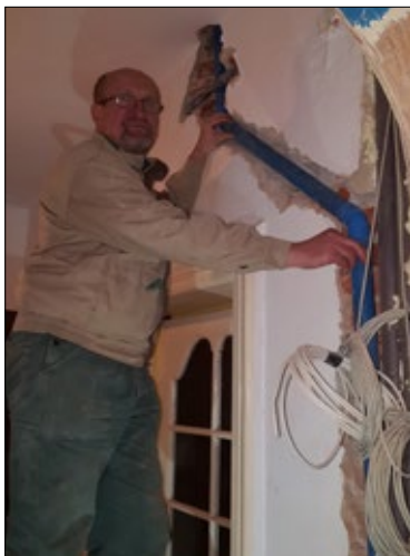
Ks. Alfred Borski w trakcie montażu instalacji centralnego odkurzacza
